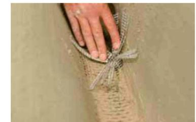
Si consiglia di prevedere lunghezze di ancoraggio pari ad almeno 20 cm per i sistemi SRP e 30 cm per i sistemi SRG/FRCM in accordo rispettivamente con i documenti CNR-DT 200 R1/2013 e CNR-DT 215/2018.
