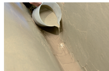
Inghisaggio degli ancoraggi con GEOCALCE FL ANTISISMICO e chiusura del foro di iniezione con apposito tappo in dotazione.
