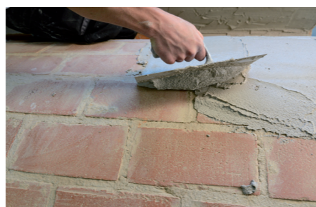
Applicazione prima mano di GEOCALCE F ANTISISMICO.
