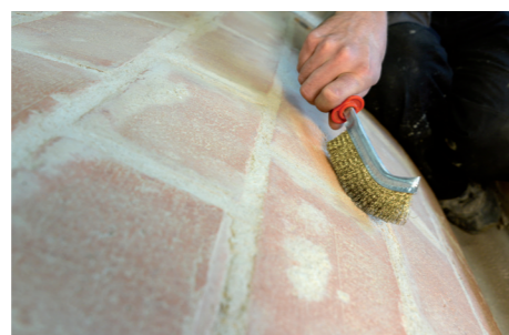
Preparazione, pulizia e umidificazione delle superfici.
