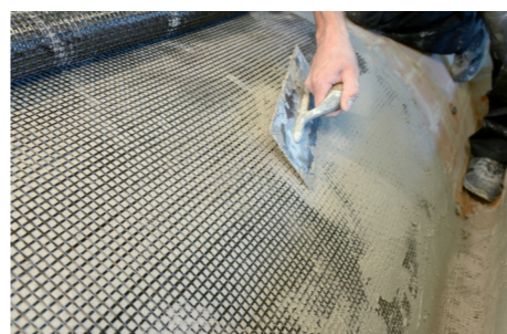
Installazione della rete biassiale in fibra di basalto GEOSTEEL GRID.
