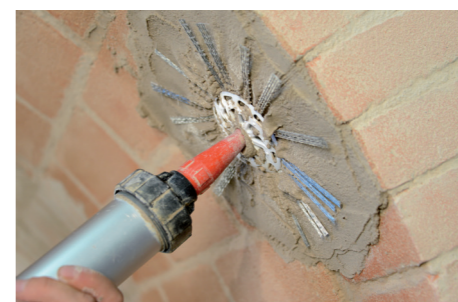
Ingisaggio dei diatoni con GEOCALCE FL ANTISISMICO.
