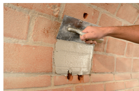
Applicazione prima mano di GEOCALCE F ANTISISMICO.
