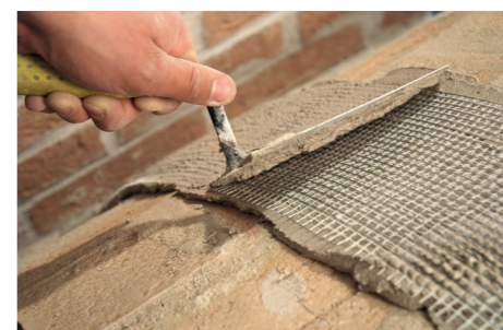
5 Applicazione seconda mano di GEOCALCE F ANTISISMICO.
