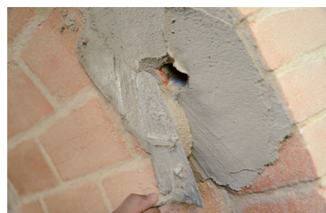
Applicazione prima mano di GEOCALCE F ANTISISMICO.
