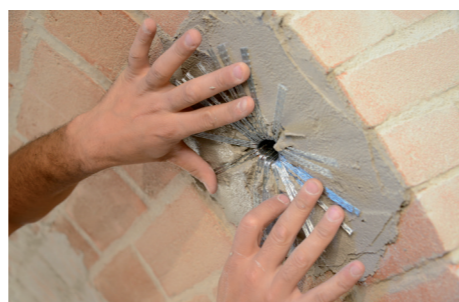
Installazione del connettore realizzato con tessuto in fibra d'acciaio GEOSTEEL.
