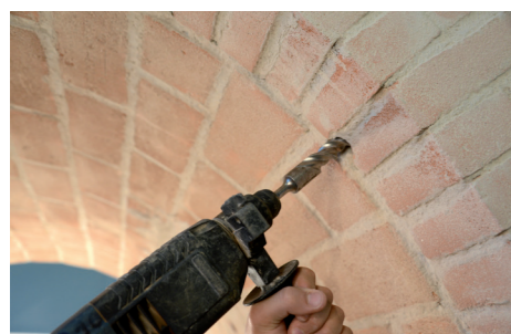
Realizzazione dei fori pilota.
