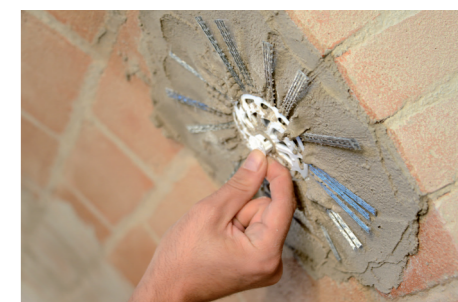
Chiusura del foro di iniezione con apposito tappo di chiusura.
