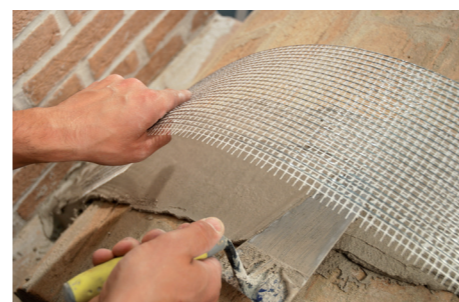
4 Installazione del tessuto in fibra d'acciaio GEOSTEEL.
