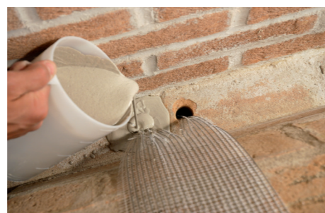
2 Inghisaggio degli ancoraggi con GEOCALCE FL ANTISISMICO.
