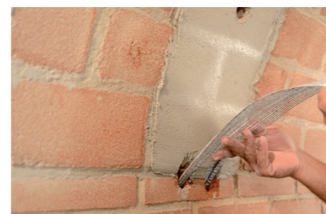
Installazione del tessuto in fibra d'acciaio GEOSTEEL.
