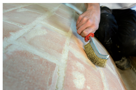
1 Preparazione e pulizia delle superfici.
