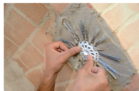
Installazione di INIETTORE&CONNETTORE GEOSTEEL.
