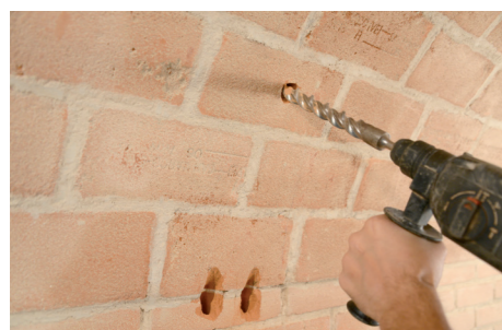
Esecuzione dei fori pilota.
