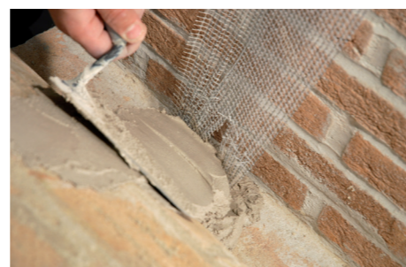
3 Applicazione prima mano di GEOCALCE F ANTISISMICO.
