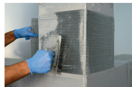
5 Applicazione fascia di tessuto in fibra d'acciaio GEOSTEEL per la cerchiatura del pilastro.
