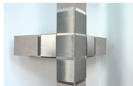
1 Verifica della corretta preparazione delle fasce di rinforzo.
