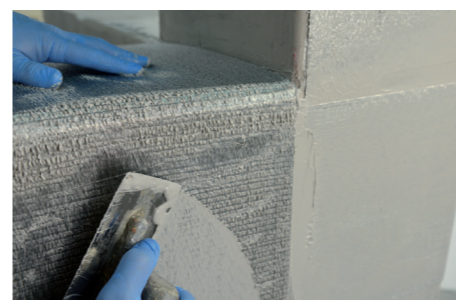
4 Applicazione fascia di tessuto in fibra d'acciaio GEOSTEEL per la cerchiatura della trave.
