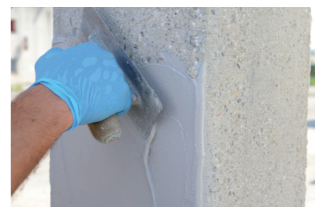
5 Applicazione prima mano di GEOLITE GEL.
