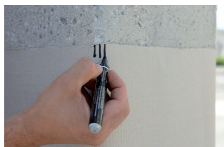
3 Indicazione delle zone di tessuto dove effettuare le piegature.
