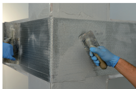
3 Applicazione fascia orizzontale di tessuto in fibra d'acciaio GEOSTEEL.
