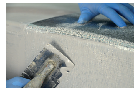
6 Installazione della fascia in spessore millimetrico.
