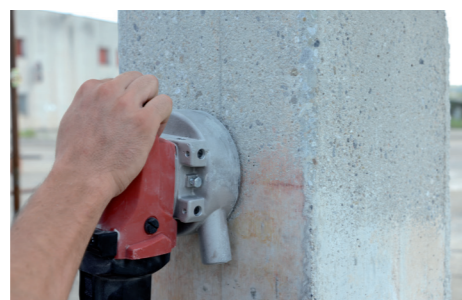
2 Preparazione delle superfici di supporto.
