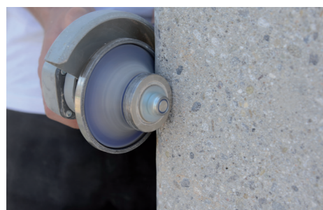
1 Smussatura degli spigoli del pilastro.
