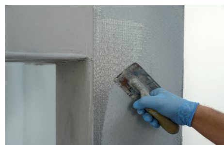
2 Applicazione fascia verticale di tessuto in fibra d'acciaio GEOSTEEL.
