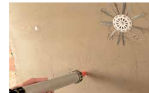
6 Ligação mecânica dos conectores com GEOCALCE FL ANTISISMICO.
