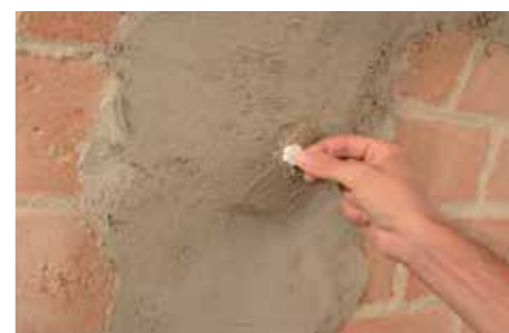
Fixação mecânica dos conectores com GEOCALCE FL ANTISISMICO e fecho do furo de injeção com a tampa de fecho própria.
