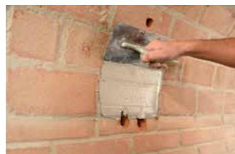
Aplicação da primeira demão de GEOCALCE F ANTISISMICO.
