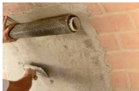
3 Instalação da rede biaxial em fibra de basalto GEOSTEEL GRID.
