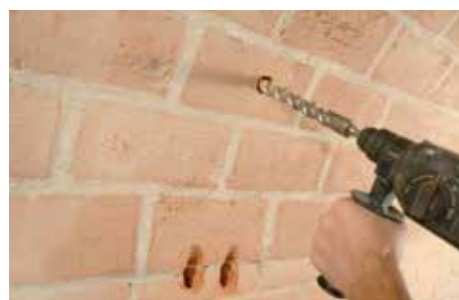
Realização dos furos guia.
