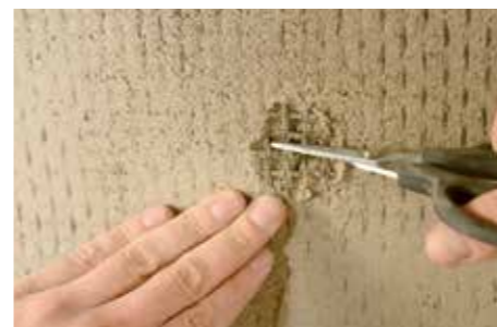
4 Corte da rede biaxial em fibra de basalto GEOSTEEL GRID no local do furo de injeção.
