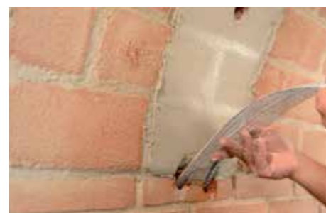
Instalação do tecido em fibra de aço GEOSTEEL.
