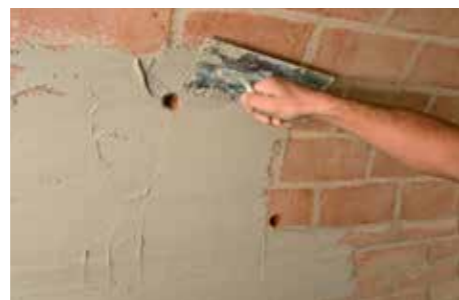
2 Aplicação da primeira demão de GEOCALCE F ANTISISMICO.
