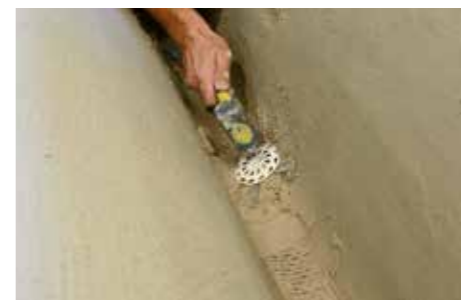
5 Instalación de diáfono GEOSTEEL e INIETTORE&CONNETTORE GEOSTEEL para la conexión entre el refuerzo y las bandas.
