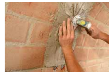
5 Instalación del conector realizado con tejido de fibra de acero GEOSTEEL con INIETTORE&CONNETTORE GEOSTEEL.
