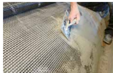
4 Instalación del tejido biaxial de fibra de basalto GEOSTEEL GRID.
