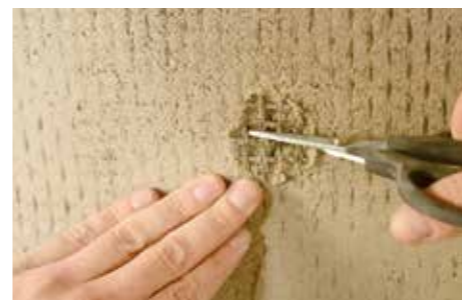
4 Corte del tejido bidireccional de fibra de basalto GEOSTEEL GRID en la zona de los agujeros a inyectar.
