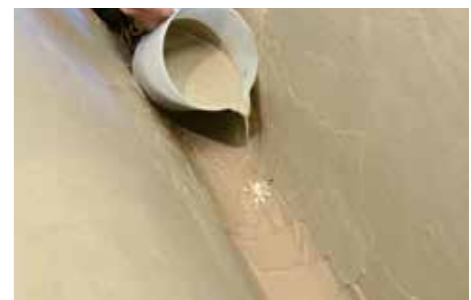
6 Fijación de los anclajes con GEOCALCE FL ANTISISMICO y cerrado del agujero con la tapa suministrada.
