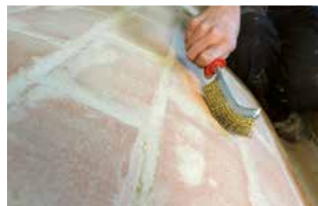
2 Preparación, limpieza y humectación de las superficies.
