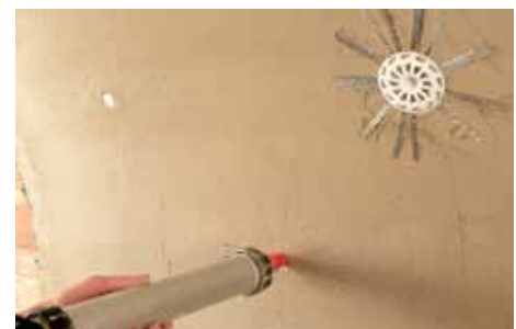
6 Anclaje de los sistemas de conexión con GEOCALCE FL ANTISISMICO.
