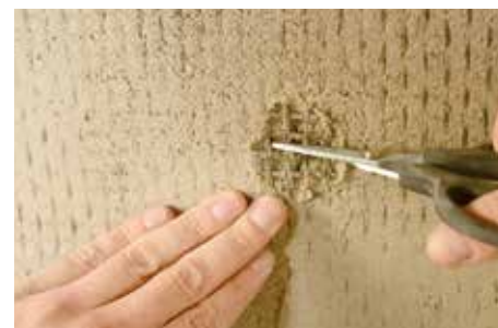
4 Corte del tejido bidireccional de fibra de basalto GEOSTEEL GRID en la zona de los agujeros a inyectar.
