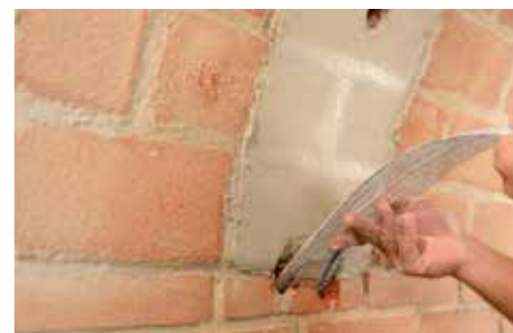
Instalación del tejido de fibra de acero GEOSTEEL.
