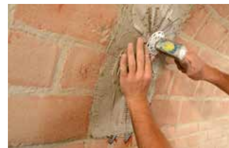
Instalación del conector realizado con tejido de fibra de acero GEOSTEEL.
