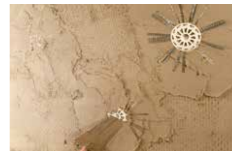
5 Instalación del conector realizado con tejido de fibra de acero GEOSTEEL con INIETTORE&CONNETTORE GEOSTEEL.
