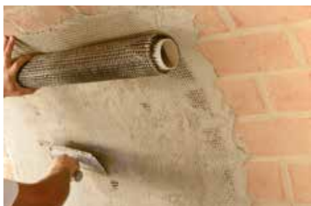
3 Instalación del tejido biaxial de fibra de basalto GEOSTEEL GRID.
