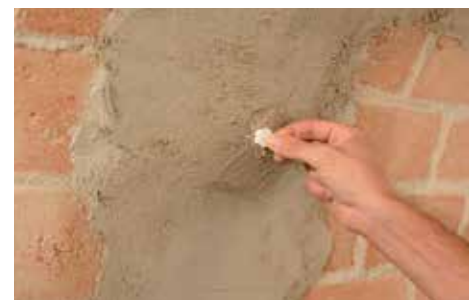
Fijación de los anclajes y de los conectores con GEOCALCE FL ANTISISMICO y cerrado del agujero con la tapa suministrada.
