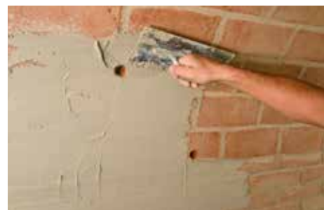
2 Aplicación de la primera mano de GEOCALCE F ANTISISMICO.
