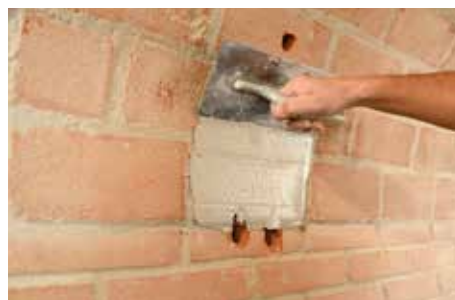
Aplicación de la primera mano de GEOCALCE F ANTISISMICO.
