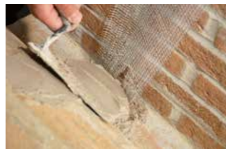
3 Aplicación de la primera mano de GEOCALCE F ANTISISMICO.
