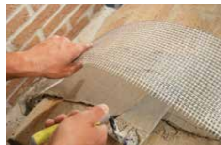
4 Instalación del tejido de fibra de acero GEOSTEEL.
