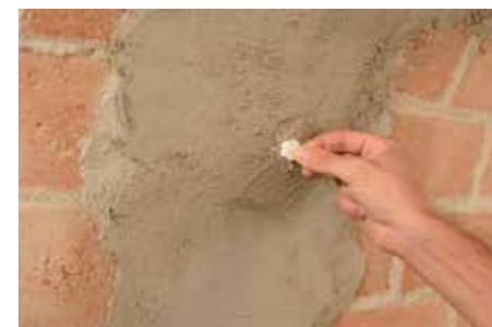
6 Fijación de los anclajes y de los conectores con GEOCALCE FL ANTISISMICO y cerrado del agujero con la tapa suministrada.
