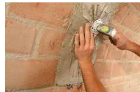
5 Instalación del conector realizado con tejido de fibra de acero GEOSTEEL.
