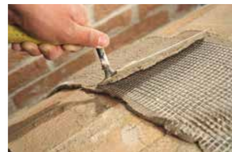
5 Aplicación de la segunda mano de GEOCALCE F ANTISISMICO.
