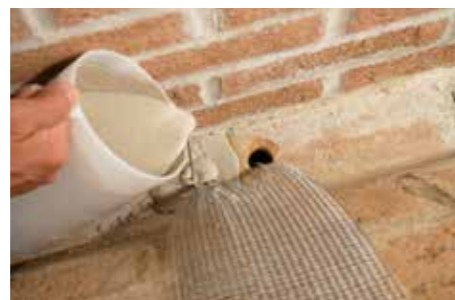
2 Fijación de los anclajes con GEOCALCE FL ANTISISMICO.
