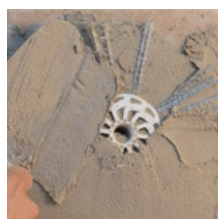
Stuccatura finale del connettore dopo l'inserimento del tassello in polipropilene
