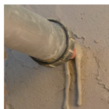
Inghisaggio del diatono mediante iniezione
