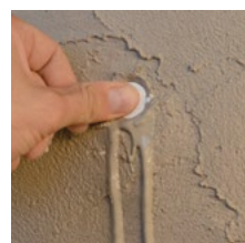
Chiusura del foro di iniezione mediante apposito tappo
